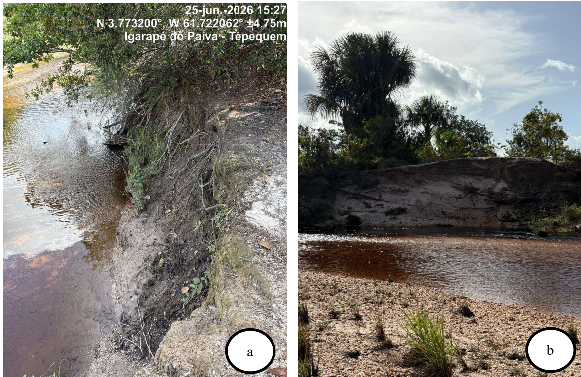
Figura 6. Evidências de instabilidade das margens e erosão associadas à ausência de cobertura vegetal no Igarapé do Paiva em (a) vista superior e (b) vista lateral.
